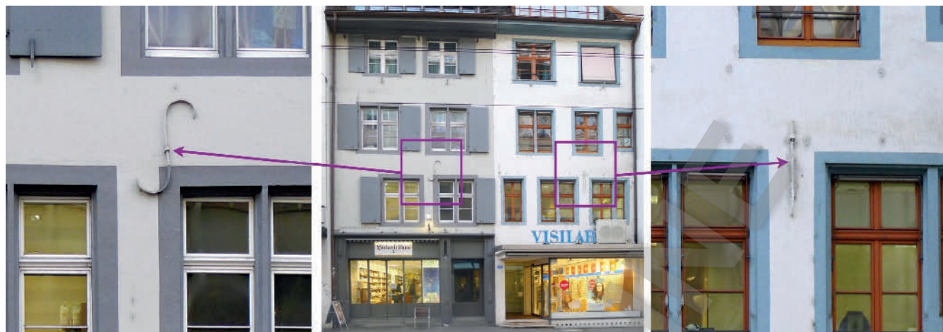
Bild 6. Fassadenanker in den Längswänden von zwei Mauerwerksgebäuden in der Basler Altstadt Abb.: T. Wenk
