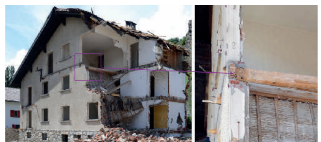
Bild 5. Beim Rückbau eines Gebäudes von 1960 (links) wird die typische Lagerung der Holzbalken mittels Einbettung über die halbe Dicke der Mauerwerkswand im Geschoss unterhalb des Holzbalkens sichtbar (rechts). Abb.: T. Wenk
