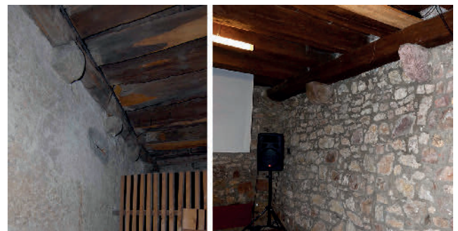
Bild 4. Streichbalken zur indirekten Lagerung der Holzbalken in mittelalterlichen Gebäuden in Basel Abb.: T. Wenk
