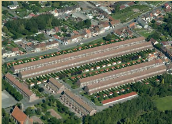
Cité de la Parisienne à DROCOURT
