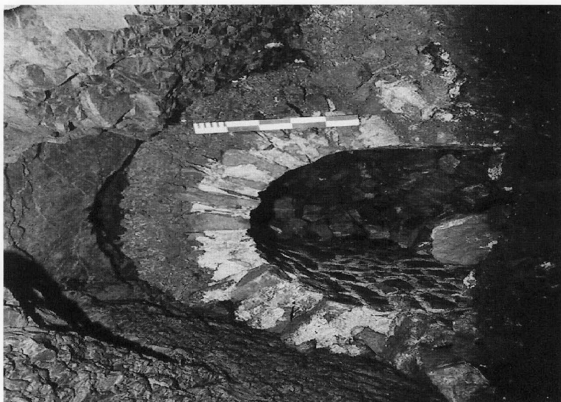
FIG. 7. Le souterrain de communication au fort Schwartzenberg, dans le flanc Sambre du fort d'Orange, en partie effondré. Photo Ph. Bragard, 1983.
