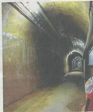
Au départ des entrailles de la station souterraine de Membach...
