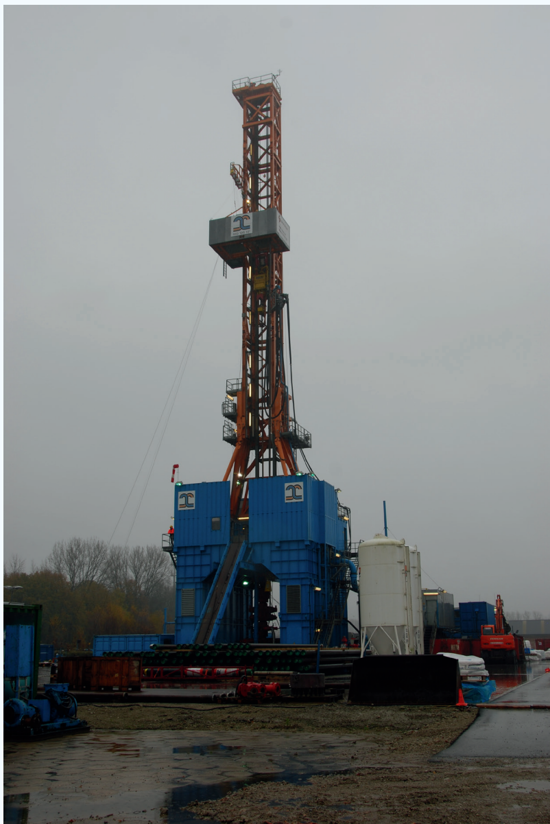
La haute tour de forage sur le site de Balmatt à Mol, où se déroule le projet pilote VITO (© IRSNB, Estelle Petitclerc)
