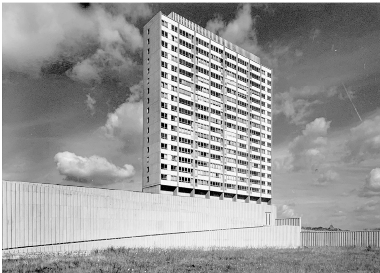
Fig. 13. Tower I - Detail of the plinth with the pilotis supporting the building and freeing up the ground; « La « Cité modèle » du Heysel à Bruxelles » by L. Novgorodsky; La technique des travaux , septembre-octobre 1966, p. 263. Emile Sergysels and Pierre Dietens
