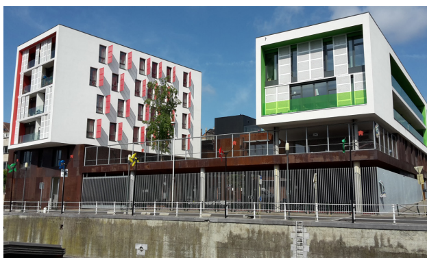
Figure 156. Ecole primaire et maternelle et 13 logements passifs à l'angle du quai de Mariemont et de la rue de Bonne.
