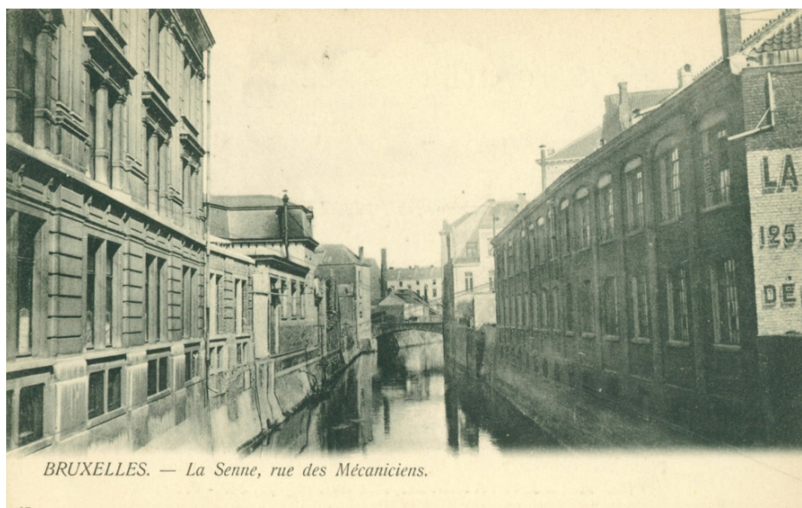
La Senne au niveau des rues des Mécaniciens (disparue) et Zérèzo (actuelle rue Georges Mathens) avant 1920 (collection cartes postales Belfius).
