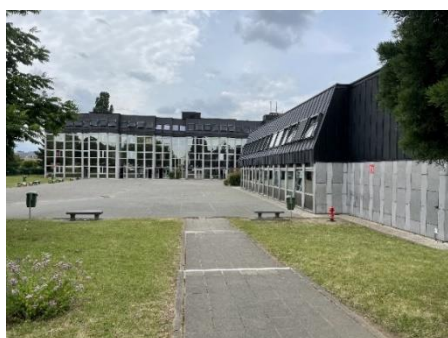
Figure 41. Vue extérieure du bâtiment principal
