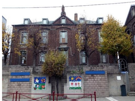
Figure 28. Bâtiment historique (A) de Ste Félicie (vue de la rue)
