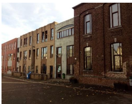
Figure 30. Bâtiment C de Ste Félicie (vue de la cour)
