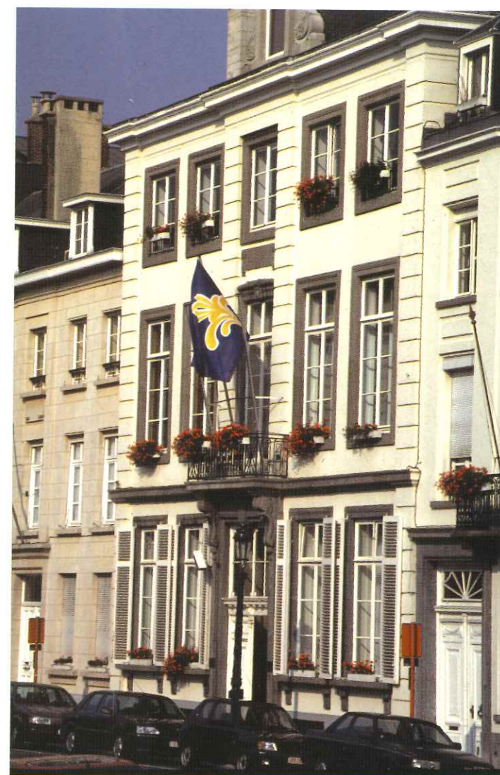
Un des bâtiments de l'exécutif de la Région de Bruxelles-Capitale © Photo: M. Vanhulst – Ministère de la Région de Bruxelles-Capitale.
